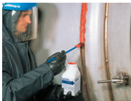
Fotografie ukazuje použití RedOne™ mořící pasty 140 u vysoce legovaného výměníku tepla 2205 (1.4462) při nízké teplotě (+8 °C).
